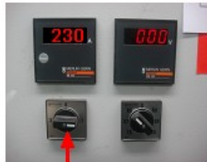
Commutateur de mise sous tension
