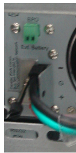
Photo 44 : Branchement onduleur.
