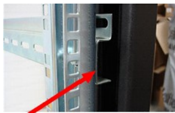
Photo 7 : Alignement des montants et barres transversales.
