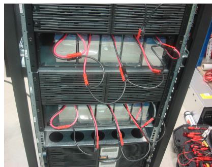
Photo 50 : Mise en place des batteries.
