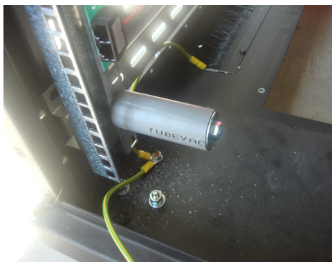
Photo 40 : fixation du tuyau.
