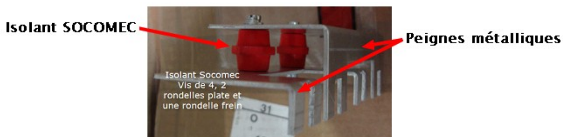
Photo 17 : Installation des isolants.
